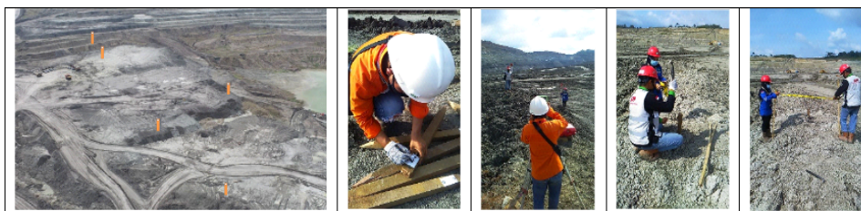
Gambar 20. Pemasangan dan Pengambilan Koordinat Patok Pantau
